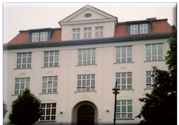
Abbildung 7: Gebäude der ehemaligen Glasfachschule.
