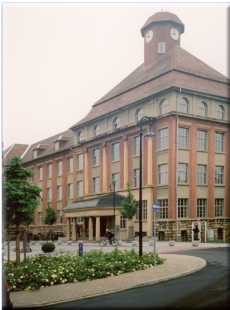
Abbildung 10: Das „Neue Technikum“ (Faradaybau) der TU Ilmenau.
