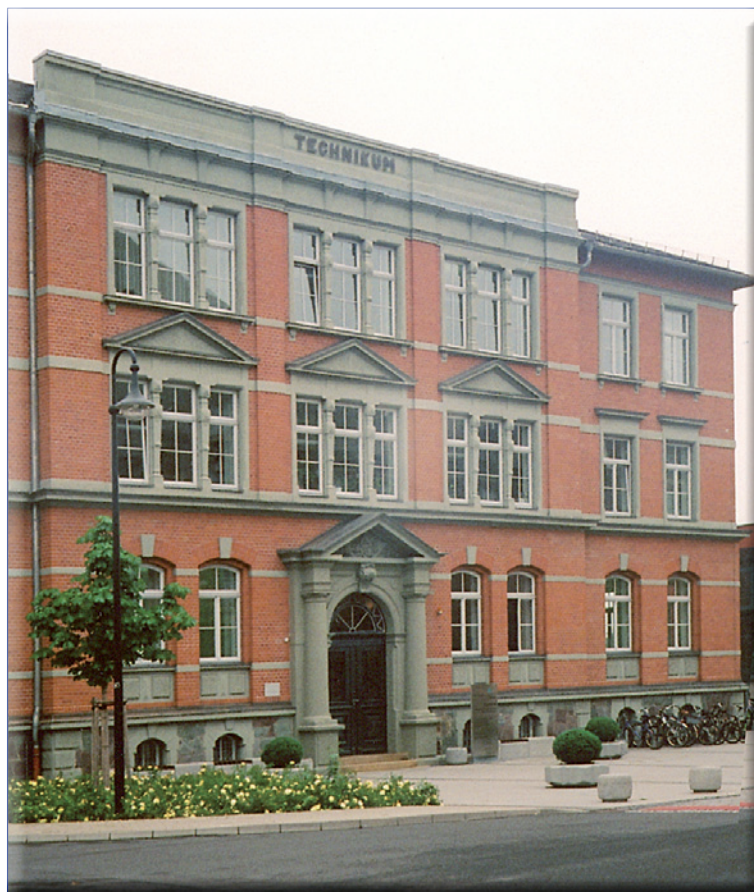
Abbildung 8: Das „Alte Technikum“ (Curiebau) der TU Ilmenau.
