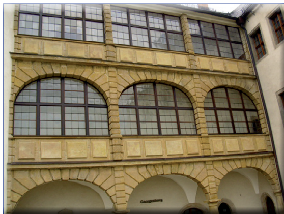
Abbildung 10: Blick auf die Fassade der Georgenburg mit Gedenktafel an den Aufenthalt Böttgers.
