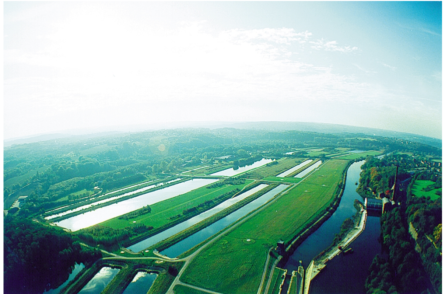
Abb. 1: Versickerungsbecken an der Ruhr: Grundwasser wird über Filterbecken mit Ruhrwasser angereichert. (Foto: Gelsenwasser AG, Gelsenkirchen).
