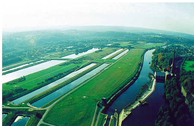
Versickerungsbecken an der Ruhr: Grundwasser wird über Filterbecken mit Ruhrwasser angereichert.
