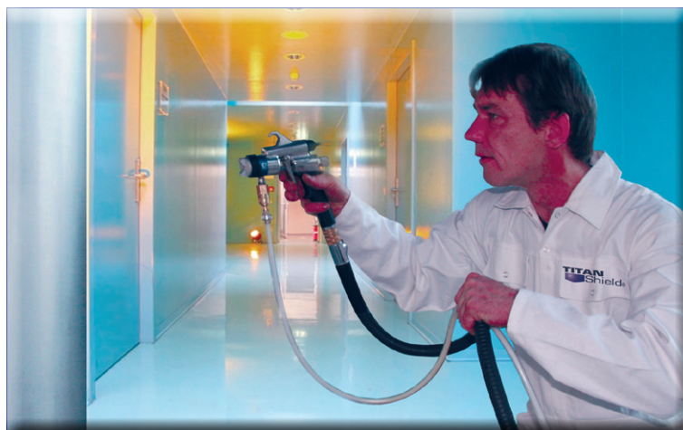
Abbildung 6: Der hauchdünne \text{TiO}_2 -Film kann einfach mit Niederdrucktechnik aufgesprüht werden [9].
