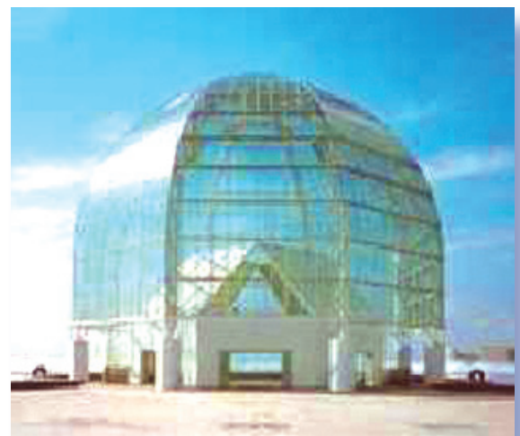
Abbildung 6: Durch spezielle Silicondichtstoffe verbundene Glaselemente zum Aufbau leicht wirkender Strukturen.
