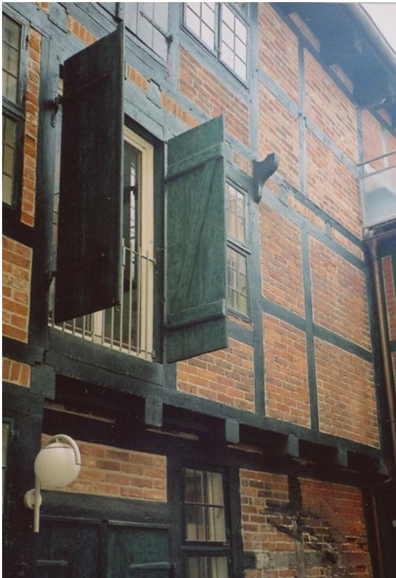
Abbildung 2: Blick vom Innenhof auf das Gebäude der Friedrichschen Seifensiederei.
