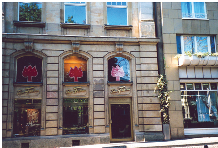
Abbildung 1: Die Fassade des nach dem Zweiten Weltkrieg wieder aufgebauten Farina-Hauses.
