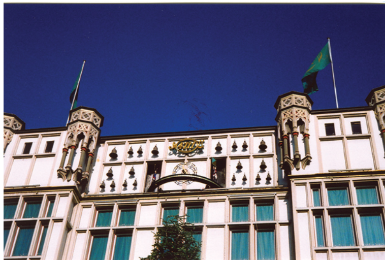
Abbildung 7: Fassade des 4711-Hauses in der Glockengasse.
