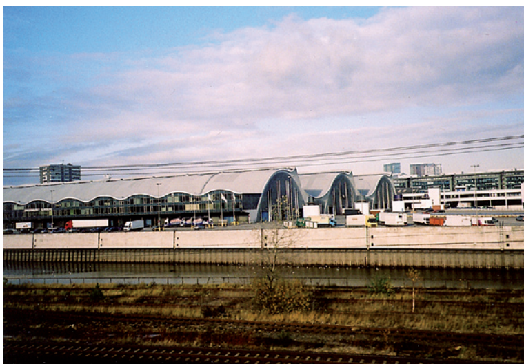
Abbildung 1: Blick aus dem Zug auf die charakteristischen Hallen des Hamburger Großmarktes (alle Fotos: Schwedt).
