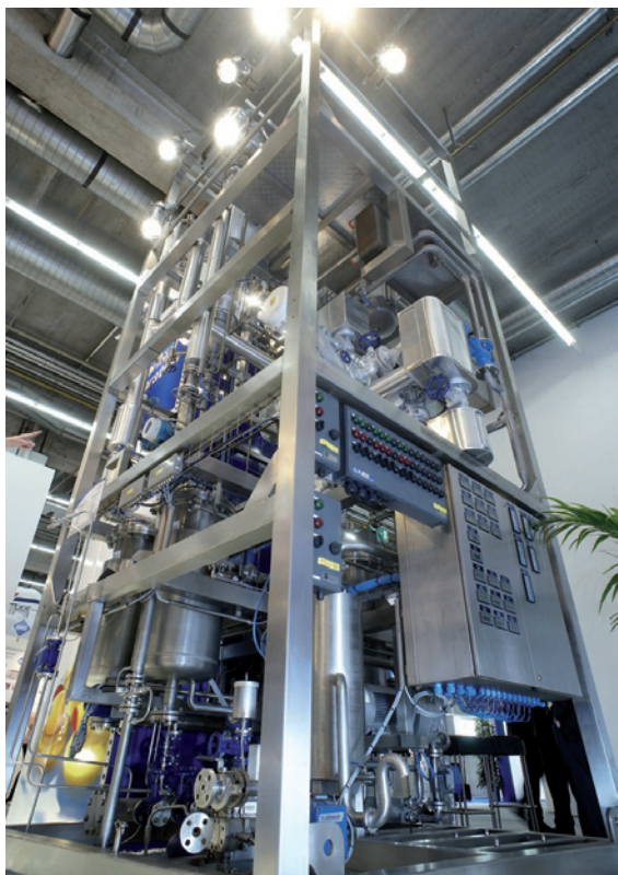
Problem beim konventionellen Anlagenbau im Chemiebereich: Kosten steigen durch den Großanlagenbau etwa bei Kraftwerken; dadurch verstärkt sich die Konkurrenz um Fachkräfte noch. Das Bild zeigt eine Dünnschichtverdampferanlage (Foto: Dechema/Stettin).
