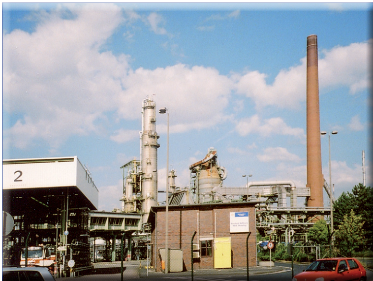
Abbildung 2: Einfahrt zur Rheinland Raffi- nerie im Süden von Wesseling.
