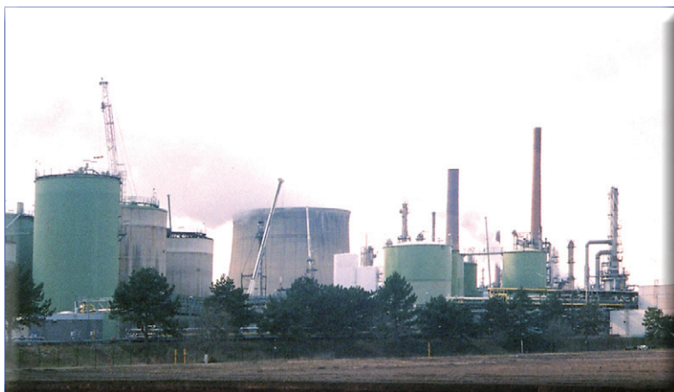
Abbildung 3: Blick auf die Anlagen der Rheinland Raffinerie vom Rheinufer.
