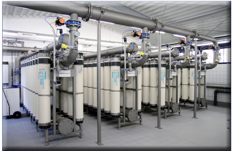
Auch die Physik hilft: Trinkwasseraufbereitung 300 m 3 /h mit Ultrafiltration im Wasserwerk Grundmühle (Foto: W.E.T. GmbH / BILD-BY).
