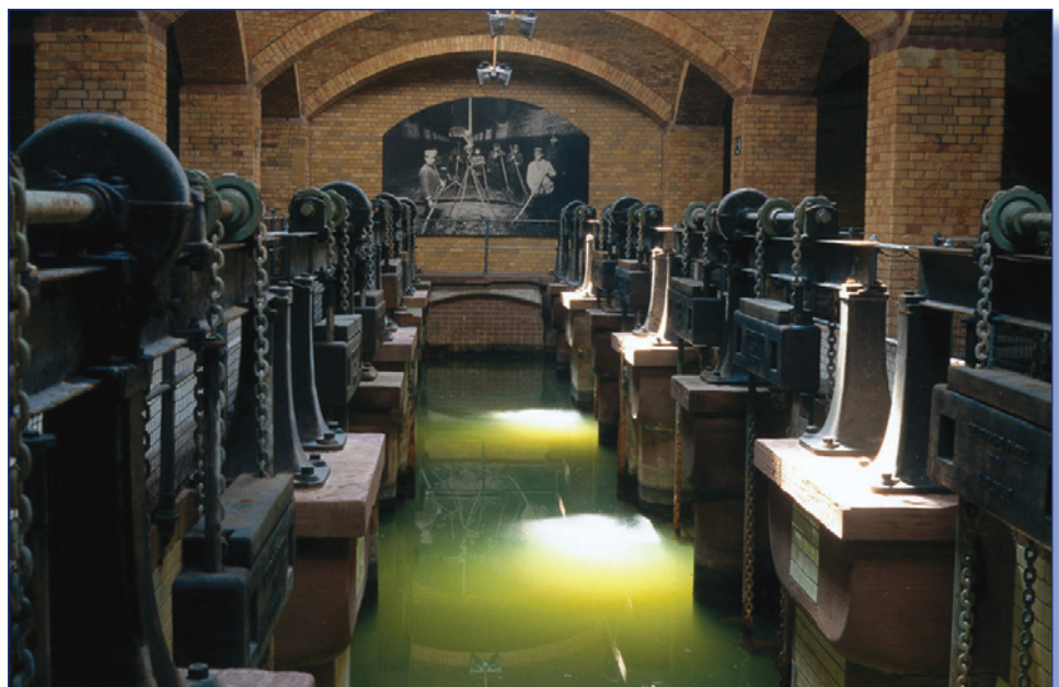
Abbildung 1: Teilansicht der Frankfurter Klärbeckenanlage, die in den Jahren 1883-1887 unter der Leitung von W.H. Lindley erbaut wurde.
