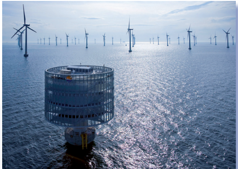
48 Siemens-Windturbinen mit einer Kapazität von 110 Megawatt machen den Windpark Lillgrund 10 km vor Schwedens Südküste aus, dem größten des Landes und z.Z. viertgrößten weltweit. Im Vordergrund die Umspannstation (Foto: Siemens).
