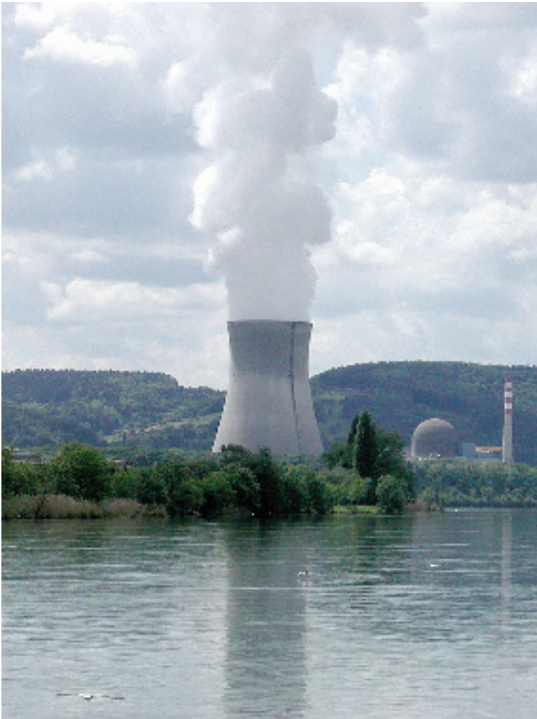
Strom aus Wind wird nur unbeständig zur Verfügung gestellt. Die Grundlast der Energieerzeugung in Deutschland wird von den großen Kraftwerken getragen. Die Kohle- und Kernkraftwerke – hier das 1165 MW-Kernkraftwerk Leibstadt am Schweizer Ufer des Rheins bei Waldshut – gewährleisten die 50-Hertz-Übertragung des Stroms durch die Netzleitungen (Foto: Kickuth).
