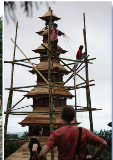
Abbildung 17: Bambusrohr beim Bau als Abstützung und Baugerüst.
