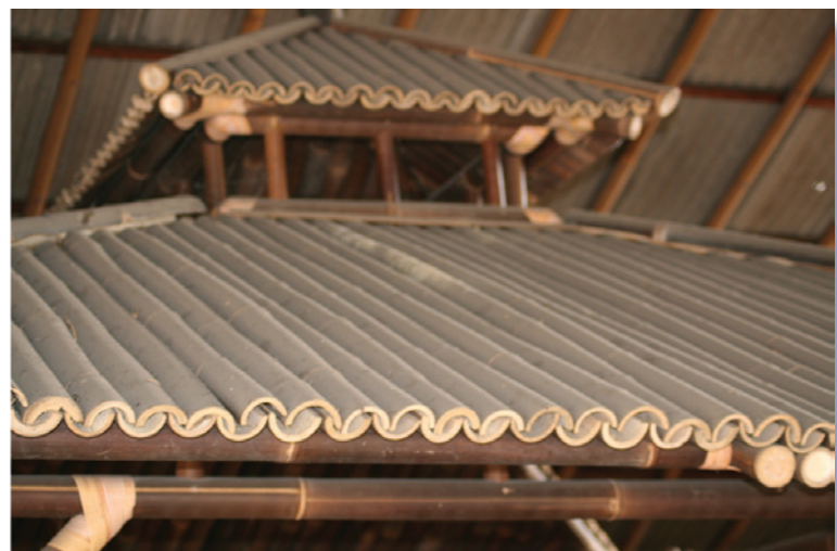
Abbildung 18: Hausbau mit Bambusrohr.
