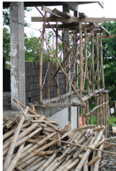
Abbildung 17: Bambusrohr beim Bau als Abstützung und Baugerüst.
