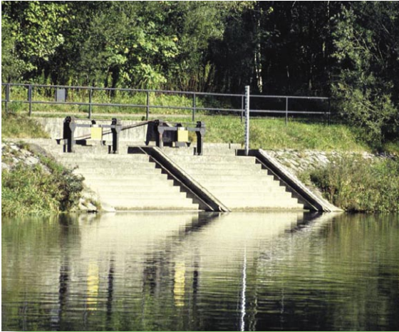
Entnahmebauwerk bei Leipheim an der Donau.
