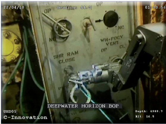
Der Greifarm eines Tauchroboters am Schalter für die manuelle Auslösung des BOP (Abb.: US Coast Guard).
