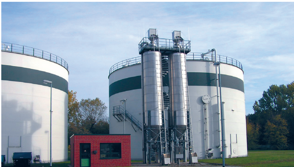
Abbildung 1: Kläranlage mit selbst regulierendem Entwässerungssystem (Fotos: hf sensor GmbH).
