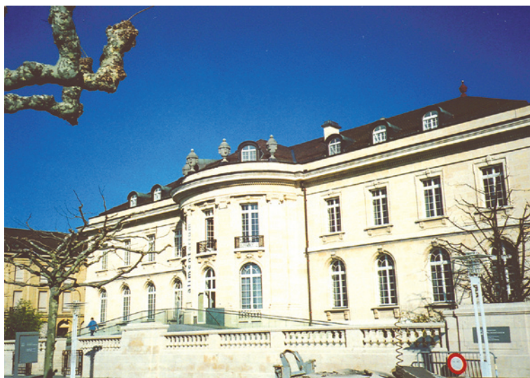
Abbildung 1: Das Gebäude des Alimentariums, vom Genfer See aus gesehen.
