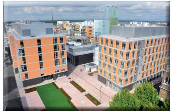
Das neue Material Research Center besteht aus zwei Laborgebäuden mit jeweils sechs Stockwerken sowie einem Reinraum-Technikum (schwarze Fassade; Foto: Merck).
