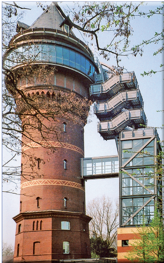
Abbildung 3: Das Wassermuseum Aquarius – Wasserturm und Glasturm mit Aufzug, gläsernem Übergang und Treppenhaus zur Plattform des Ruhrlandpanoramas.
