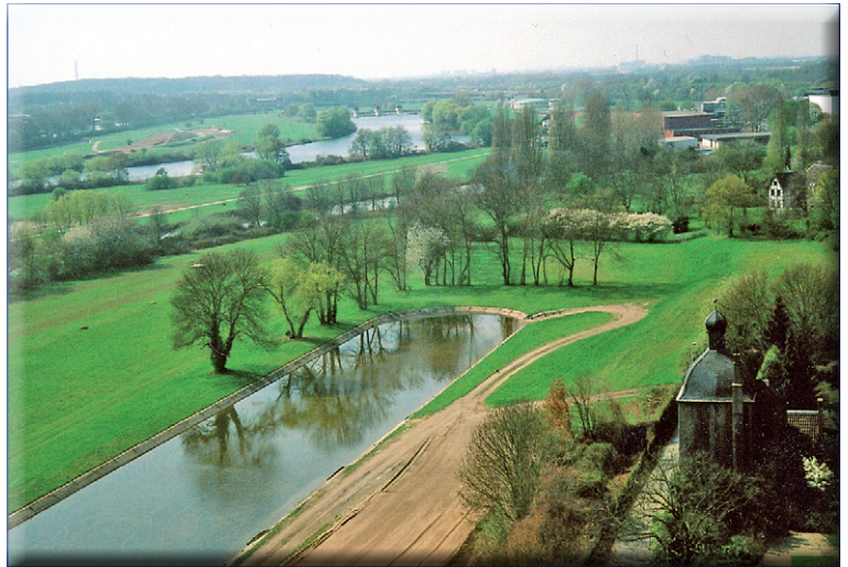
Abbildung 2: Blick auf das Langsamsandfilterbecken der RWW und auf die Ruhr von der Ebene „Ruhrlandpanorama“ des Wasserturms.
