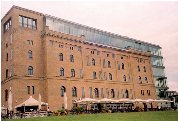
Abbildung 6: Die Fassade der historischen Rohmühle mit Restaurant.
