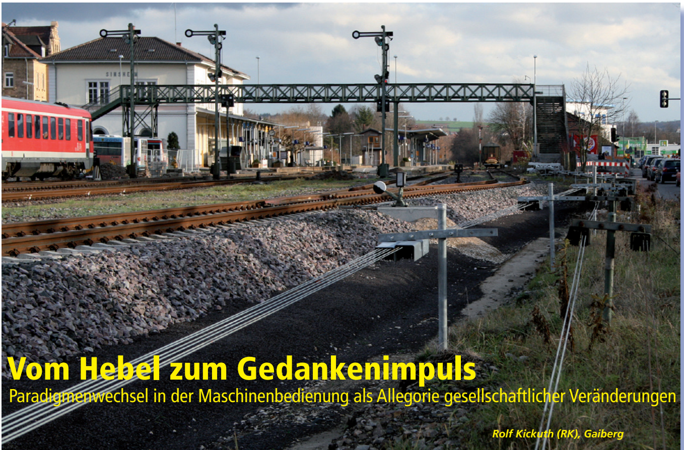
Abbildung 1: Noch steuern Seilzüge Signale und Weichen des Bahnhofs Sinsheim im Kraichgau (Foto: RK).
