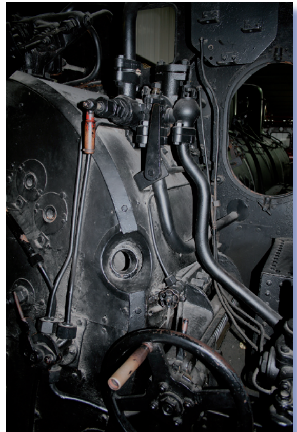
Abbildung 3: Teil des Lokführerstandes einer Henschel Rangierlok von 1946: Mit Schiebern, Hebeln und Ventilen steuerte man das Dampfross (Foto: RK).
