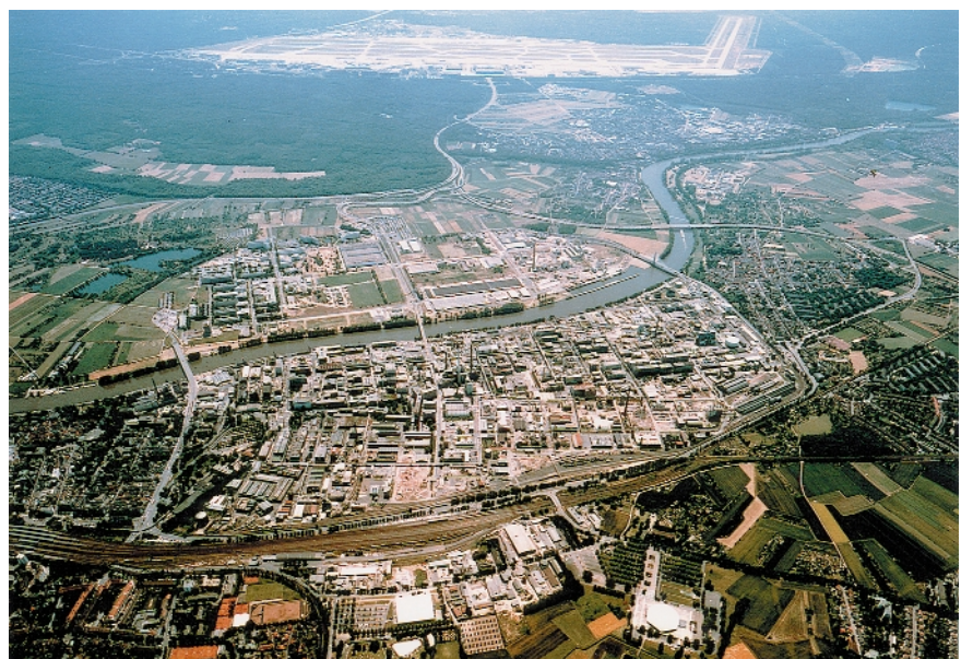
Der Industriepark Höchst. In der Bildmitte der Main, am oberen Bildrand der Flughafen Frankfurt. Die mehr als 50 im Industriepark Höchst operierenden Firmen werden von der Infraserv Höchst mit rund 6500 unterschiedlichen Dienstleistungen versorgt (Foto: InfraServ Höchst).
